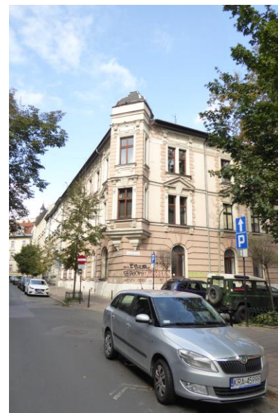
Rysunek 5 Przykładowy budynek ujęty w gminnej ewidencji zabytków pod adresem ul. Bonerowska 2/ ul. Librowszczyzna 5.
