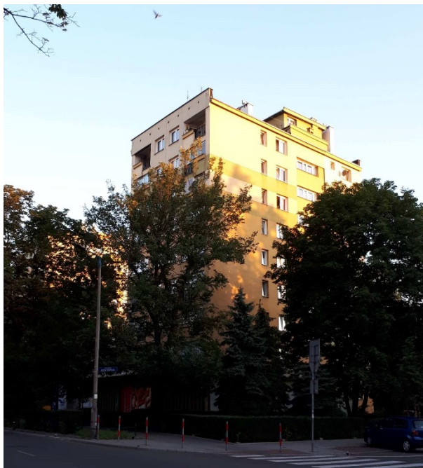
Fot. 2. Zabudowa 9-kondygnacyjna w ternie MNW (u zbiegu ul. Kazimierza Wielkiego i pl. Axentowicza)
