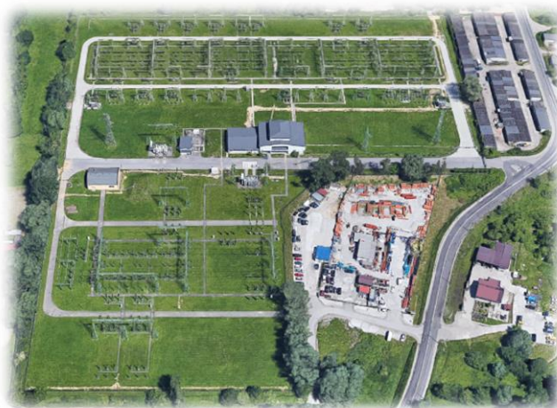
Rys. 14 Stacja elektroenergetyczna „Wanda” Źródło: Google Maps
