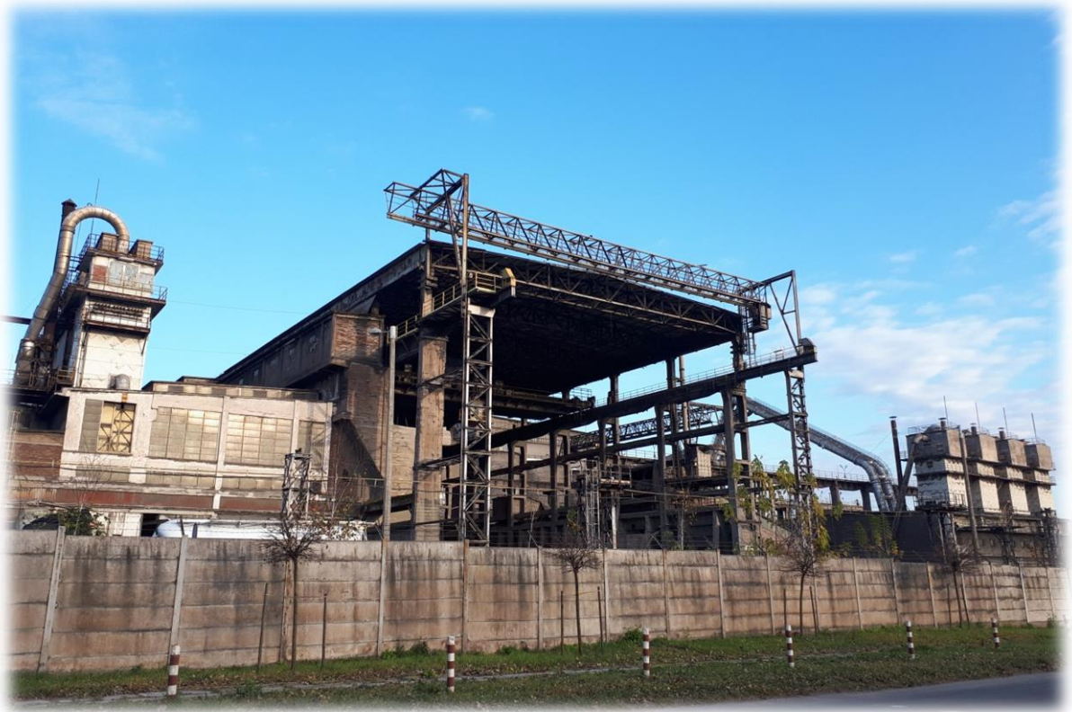
Fot. 17 Cementownia Kraków - Nowa Huta przy ul. Cementowej (w sąsiedztwie pętli Pleszów)
