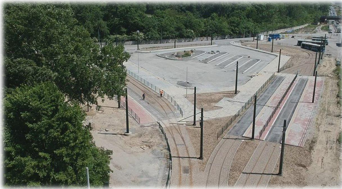
Fot. 22 Zmodernizowana pętla w Pleszowie
