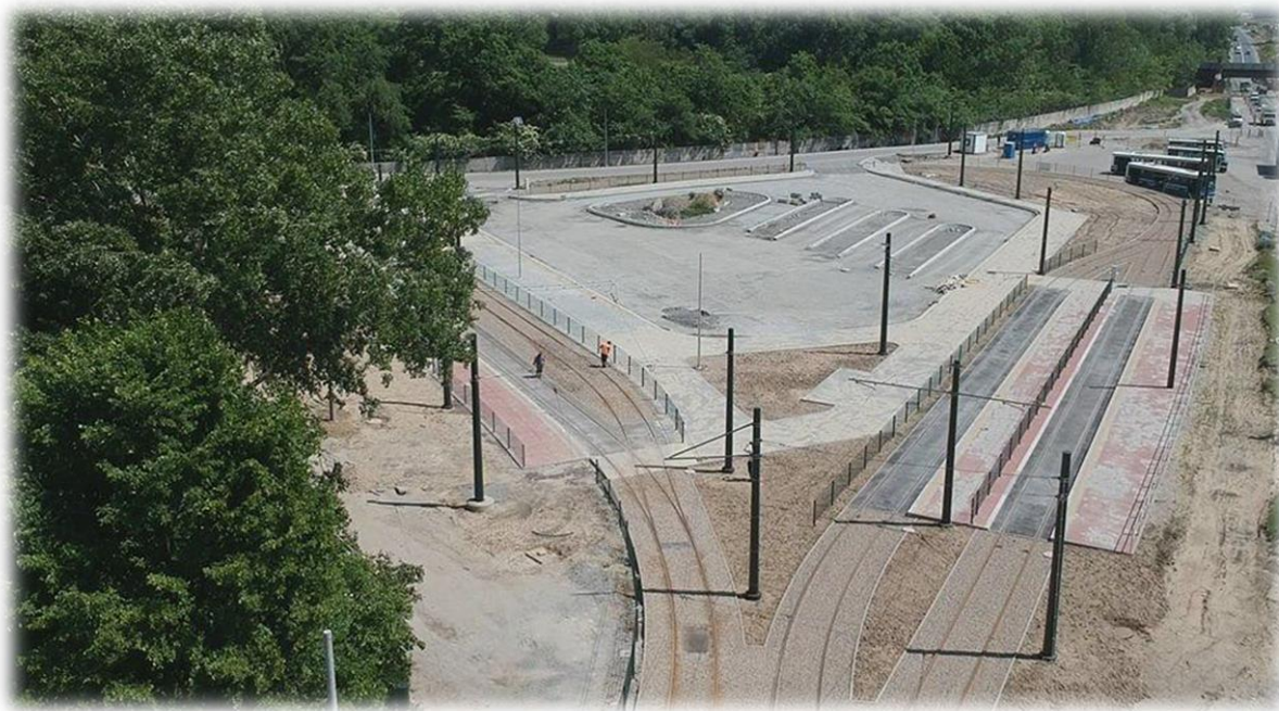
Fot. 22 Zmodernizowana pętla w Pleszowie
