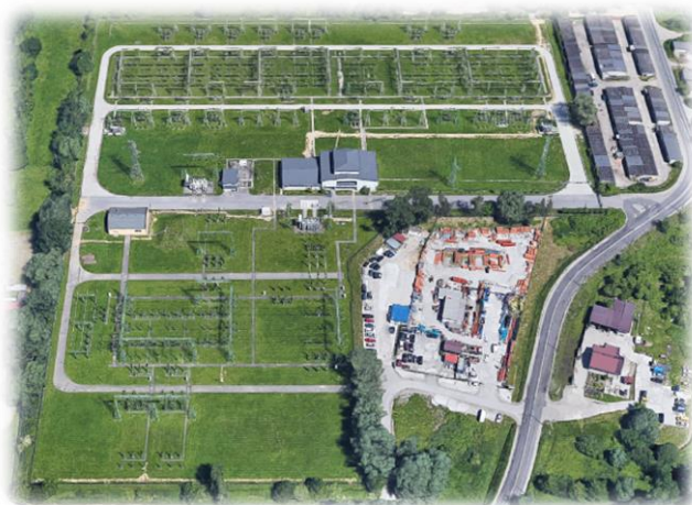
Rys. 14 Stacja elektroenergetyczna „Wanda” Źródło: Google Maps
