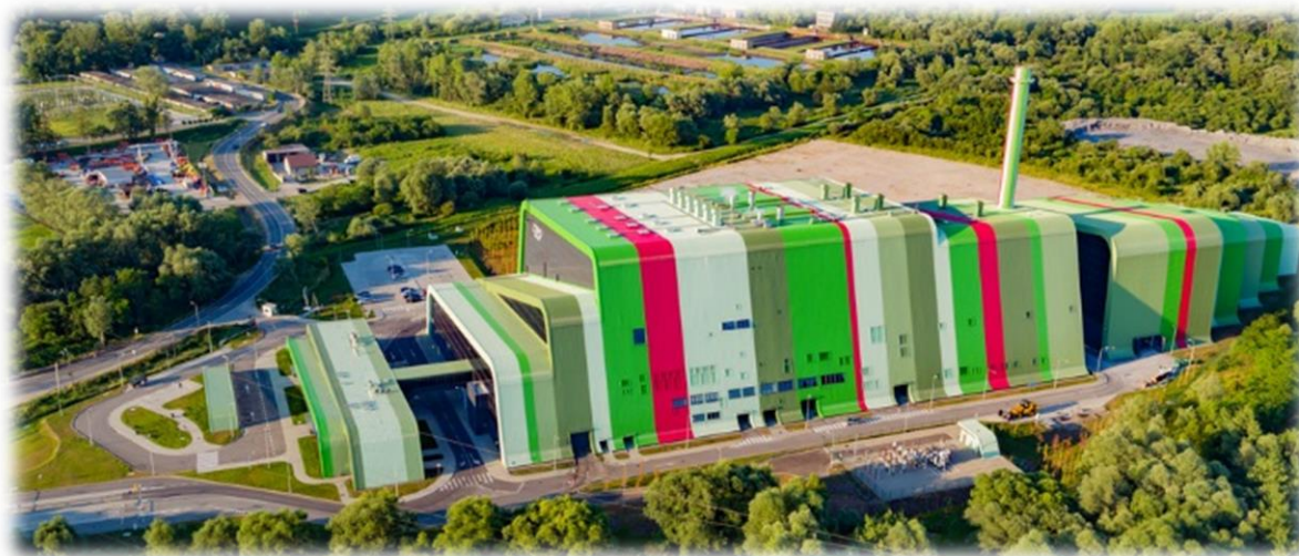
Fot. 20 Zakład termicznego przetwarzania odpadów Źródło: khk.krakow.pl
