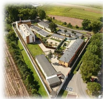
Fot. 19 Zakład karny Kraków – Nowa Huta Źródło: www.sw.gov.pl
