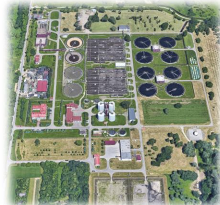
Rys. 13 Zakład Oczyszczania Ścieków „Kujawy” Źródło: Google Maps
