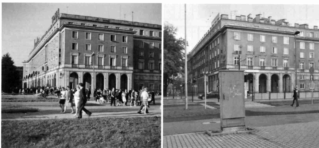
Infrastruktura techniczna żyje własnym życiem, szpecąc bez potrzeby miasto – plac Centralny, Centrum A
