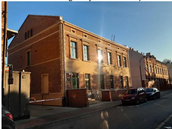
Rysunek 5 Przykładowy budynek wpisany do rejestru zabytków pod adresem ul. Żółkiewskiego 17 - dom dyrektora fabryki Petereisma. Źródło: Z archiwum BP UMK/.
