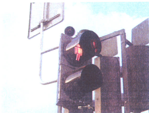
Fot. 25-26. Sygnalizacja świetlna z udźwiękowieniem w Rondzie Mogilskim.
