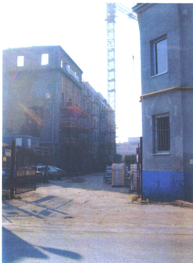
2008 - budowa loftów w „Młynie Ziarno”
