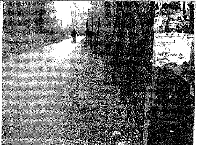
Widok ku wschodowi na naprawiony odcinek drogi
