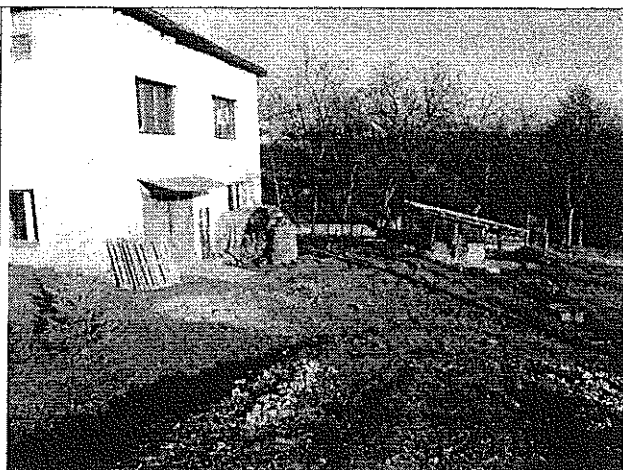
Widok na skarpe osuwiska pod budynkiem gospodarczym ul. Kaszubska nr 6, częściowo wyrównane i odwodnione.
