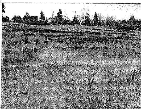
Środkowa część osuwiska – widok z dołu
