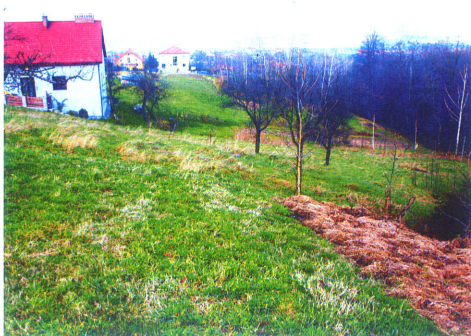
Nieczynne osuwisko „c”, widoczna skarpa boczna ograniczająca osuwisko od północy
