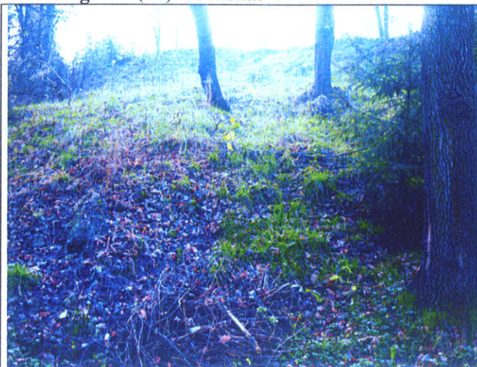
Osuwisko „a” – skarpa główna
