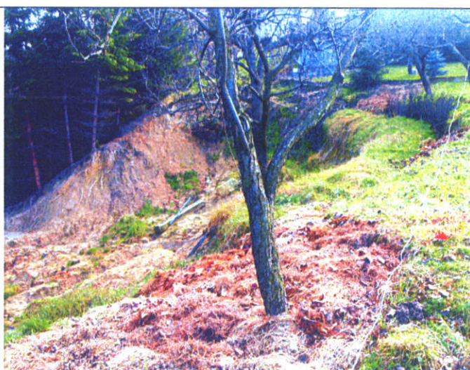
Górna część osuwiska „b”
