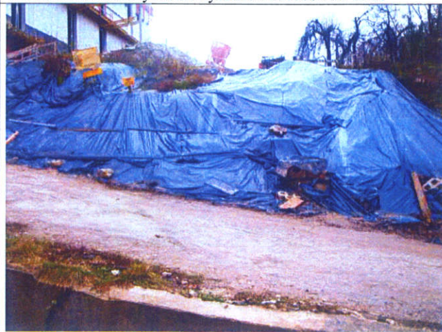
Osuńnięcia gruntów na działce nr 83/1
