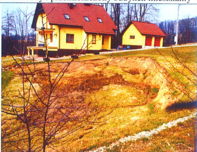
Skarpa główna osuwiska
