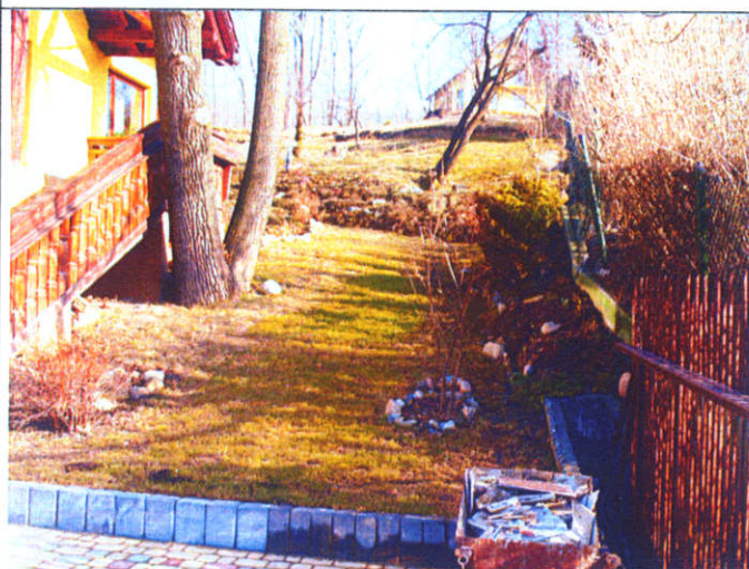
Przemieszczenia powyżej budynku 12g
