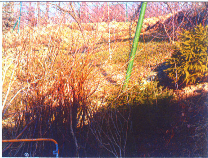
Zniszczone ogrodzenie w górnej części osuwiska
