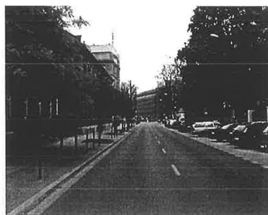
Zdjęcie 7. Przebudowana ul. Szlak
