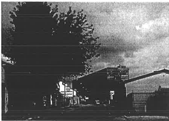
Zdjęcie 17. Stan techniczny zabudowy – ul. Romanowicza
