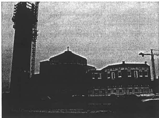
Zdjęcie 20. Budowa Centrum im. Jana Pawła II
