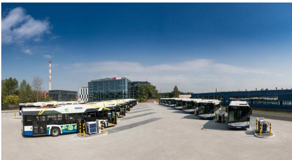
Fot. 1 Stacja ładowania pantografowego na terenie SOA Wola Duchcka, ul. Walerego Sławka 10.
