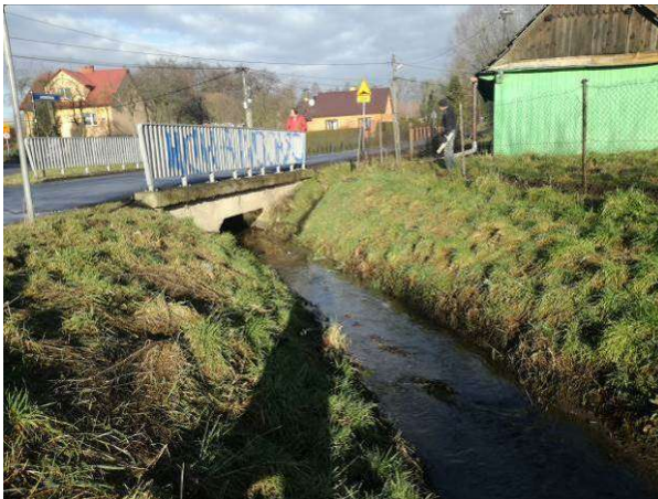
Rys. 51: Widok mostku na Strudze Rusieckiej przy ul. Zagościniec od południowej strony (I 2018).
