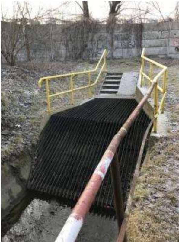
Rys. 21: Krata wlotowa do kanału HAM, widok od strony napływu (foto III 2018).
