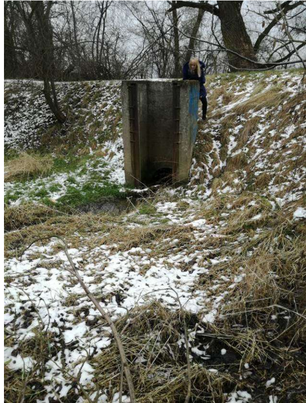
Rys. 175: Widok budowli spustowej ze stawu (foto II 2018).
