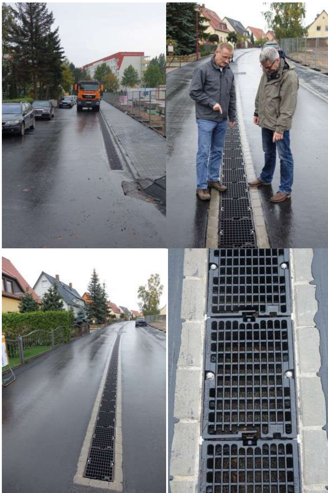
Rys. 162: Przykładowe zastosowanie liniowego systemu odwodnienia z podczyszczeniem D-Rainclean® w Coswig (źródło: https://www.kommunaldirekt.de/d-rainclean-system-fuer-drei-strassenzuege/ ).
