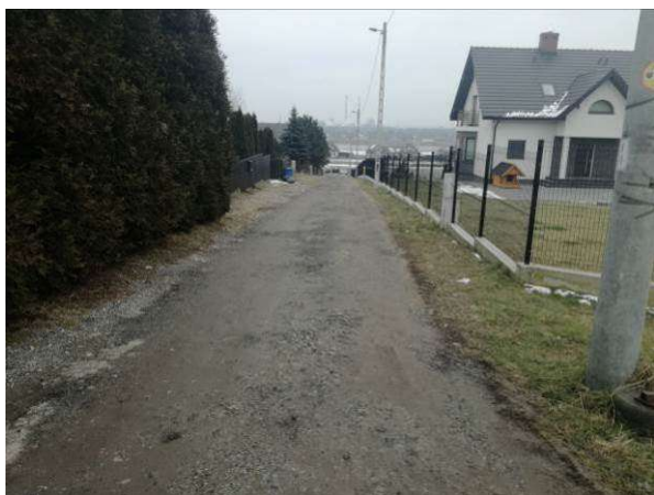
Rys. 40: Widok z początku ul. Birkuta w kier. południowym (foto II 2018).
