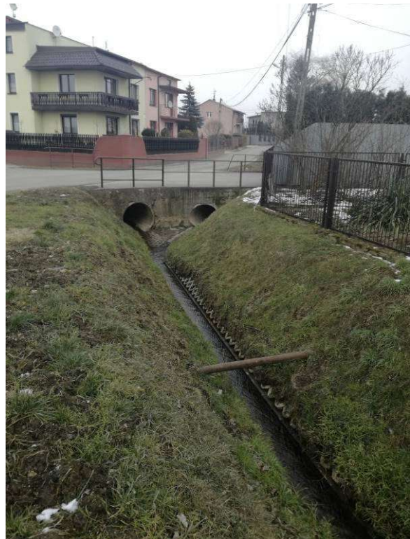
Rys. 69: Przewód gazowy przekraczający rów przy ul. Niewielkiej (12) (foto: III 2018).
