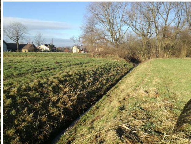
Rys. 172: Widok SR w kierunku odpływu, ok. km 0+050 (foto I 2018).
