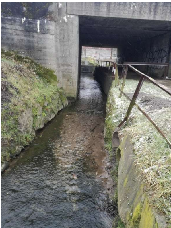
Rys. 20: Kanał napływowy na kratę, widok na wiadukt i kratę od strony ul. Burzowej (foto III 2018).
