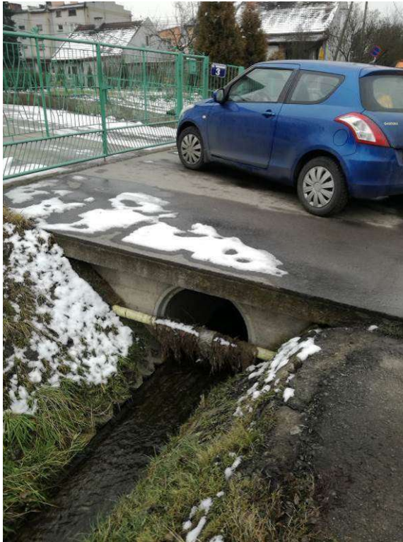
Rys. 58: Widok na przekroczenie rowu gazociągiem w okolicy ul. Burzowej (1) (foto: III 2018).
