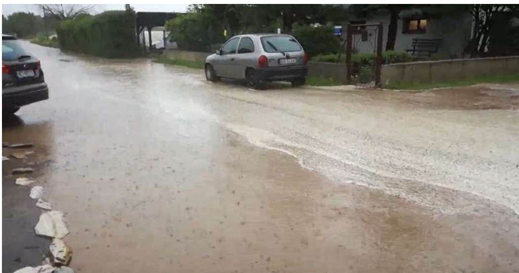
Rys. 48: Podtopienie ul. Kantorowickiej na północ od Baranówki, na wys. posesji nt 199, widok w kier. północnym (fot. K. Maczuga, 2017).
