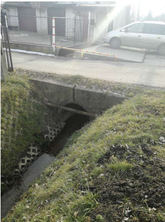
Rys. 68: Przewód gazowy przekraczający rów przy ul. Niewielkiej (11) (foto: III 2018).
