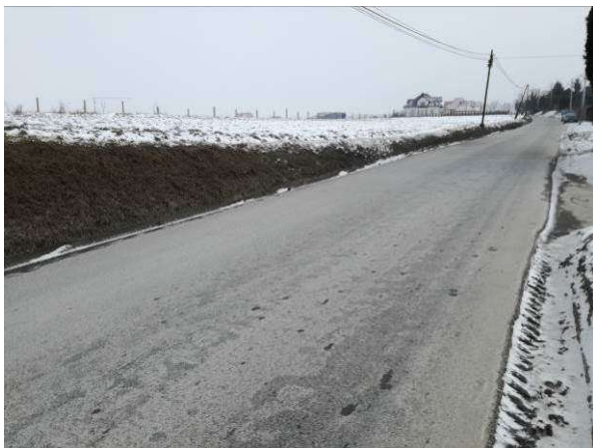
Rys. 42: Widok ul. Kocmyrzowskiej spod posesji nr 135 w kier. południowo-wschodnim, widok na pola, z których wody spływają na jezdnię (II 2018).
