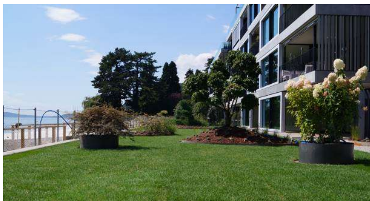
Rys. 141: Przykład placu retencyjnego w trakcie przygotowania i po zakończeniu prac budowlanych ( https://www.schwabgartenbauag.ch/referenzen/beauvillage-biel )
