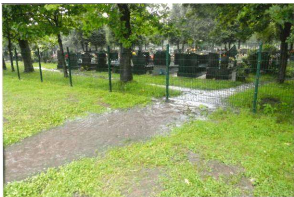
Rys. 54: Odpływ z terenu cmentarza przelewający się do rowu przydrożnego przy ul. Darwina (fot. A. Wójcik VI 2017).
