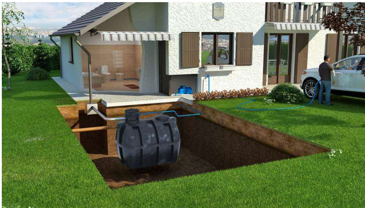
Rys. 156: Wizualizacja funkcjonowania podziemnego zbiornika na deszczówkę, dedykowanego do zastosowania na prywatnych posesjach ( http://hurtowniaoczyszczalni.eu/?43,zbiornik-na-deszczowke-delfin )
