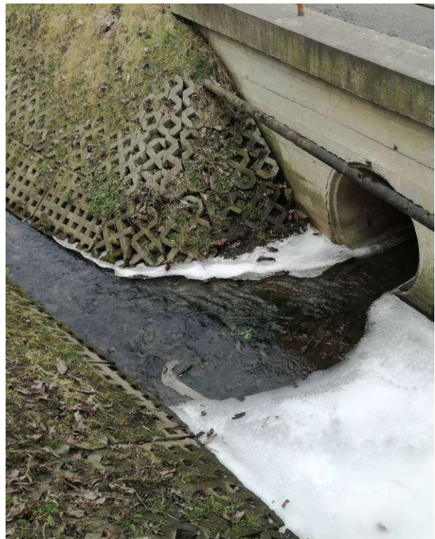
Rys. 65: Przewód gazowy przekraczający rów przy ul. Niewielkiej (8) (foto: III 2018).
