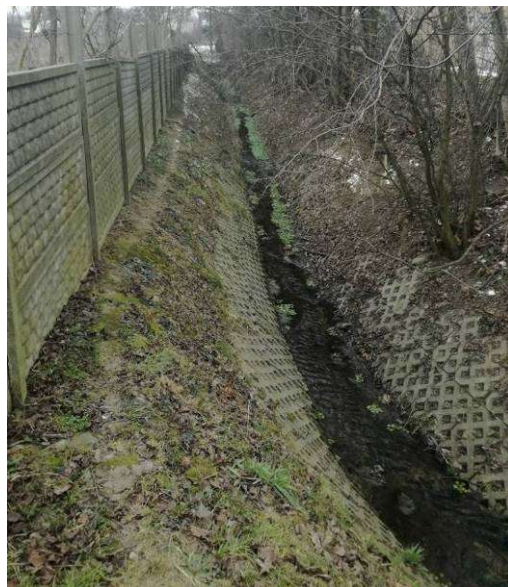
Rys. 27: Fundamentowane ogrodzenie barierą dla odpływu powierzchniowego z przyległego terenu do „R łącznik”.
