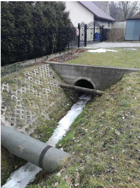
Rys. 64: Przekroczenie rowu wodociągiem – okolice ul. Godebskiego (7) (foto: III 2018).
