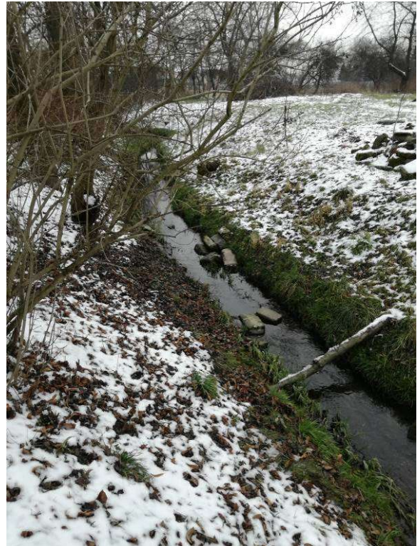
Rys. 59: Widok na przekroczenie rowu rurociągiem ks150 pomiędzy ulicami Darwina i Lubocką (2) (foto: III 2018).
