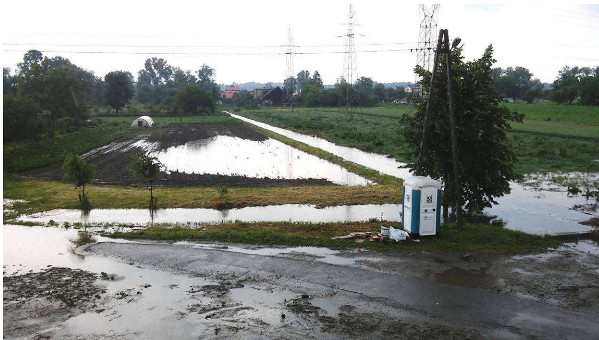
Rys. 35: Widok przepelnionego rowu „R Lubocka 1” z nasypu kolejowego w kierunku napływu (foto: S. Gazarkiewicz, 02.06.18).
