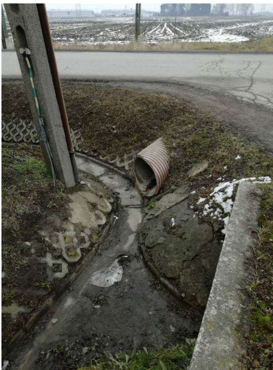
Rys. 32: Wylot nie uzgodnionego przelewu z pola do „R GzSanoka” (foto: II 2017).
