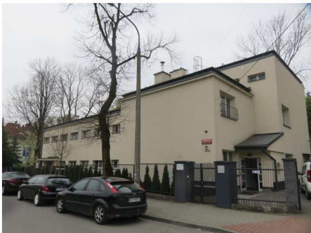
Fot. 1 Widok ogólny obiektu
