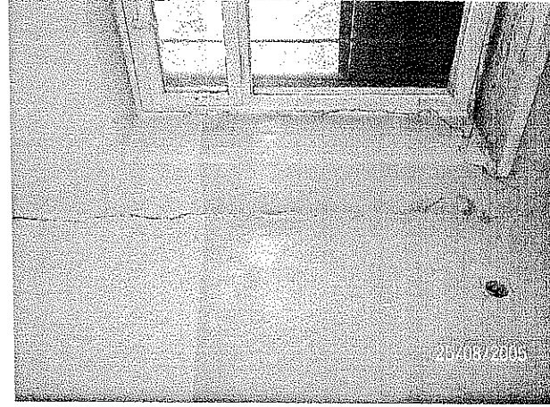
fot.10 i 11 – pęknięcie i odchylenie się ściany zewnętrznej w pr-wsch. narożniku budynku
