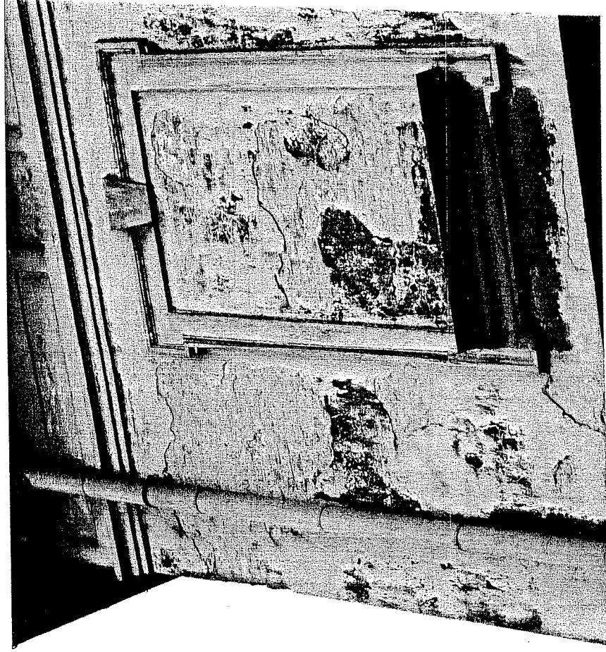
Fot. 3. Kraków, ul. Józefińska 14. Elewacja kamienicy od strony ul. Józefińskiej. Fragm. Ubytki tynków do wątku ceglanego.
