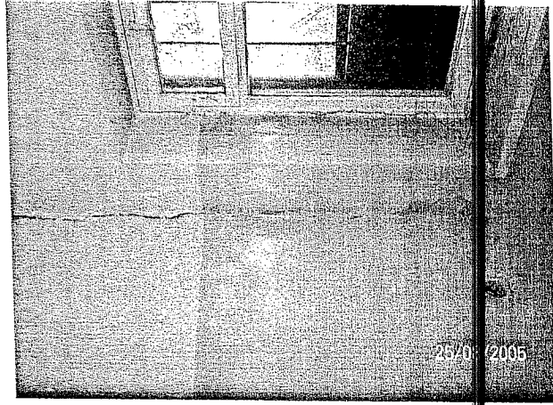
fot.10 i 11 – pęknięcie i odchylenie się ściany zewnętrznej w pn-wsch. narożniku budynku
