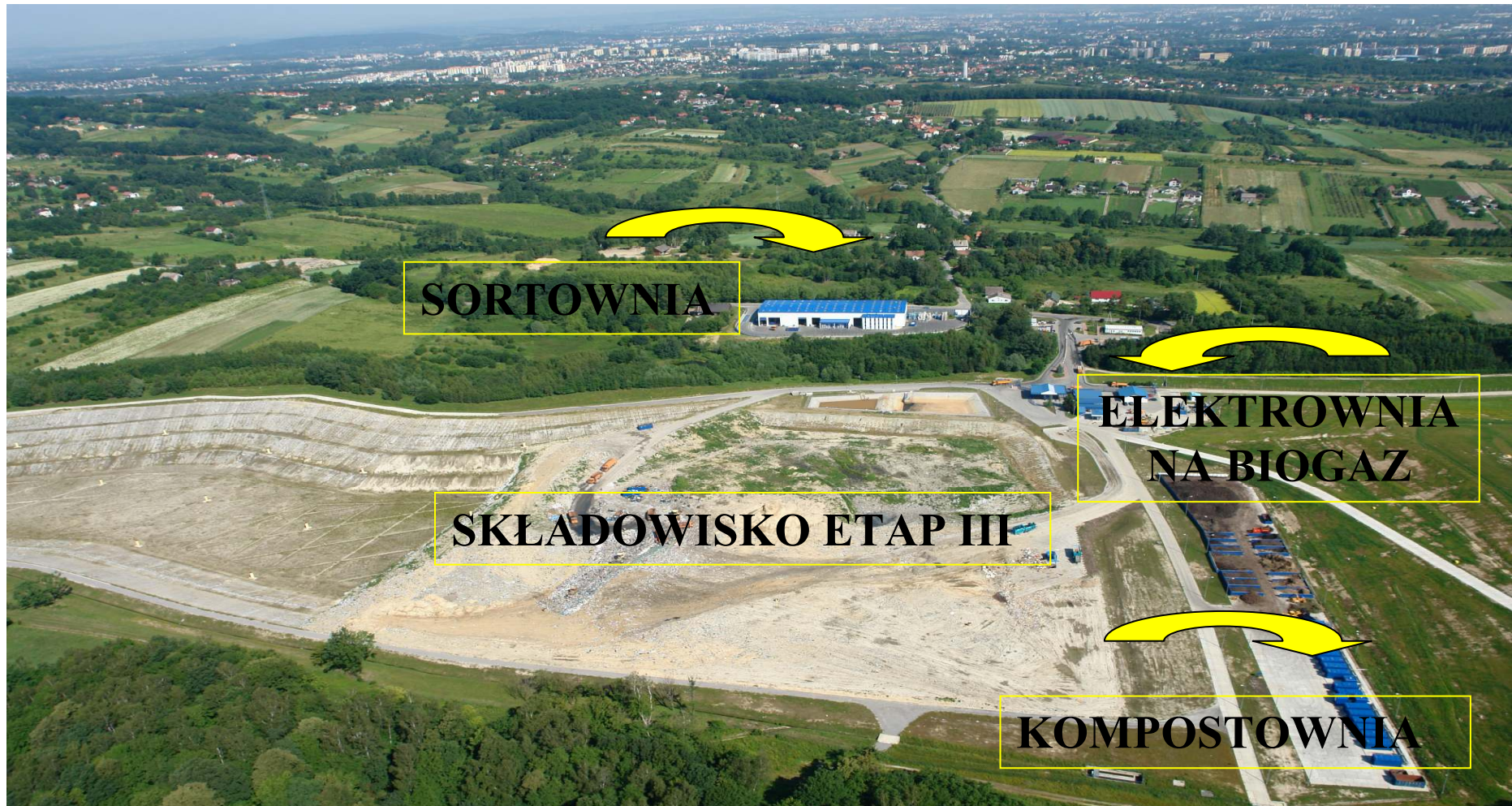
Rysunek 15. Instalacje do odzysku i unieszkodliwiania odpadów komunalnych BARYCZ
