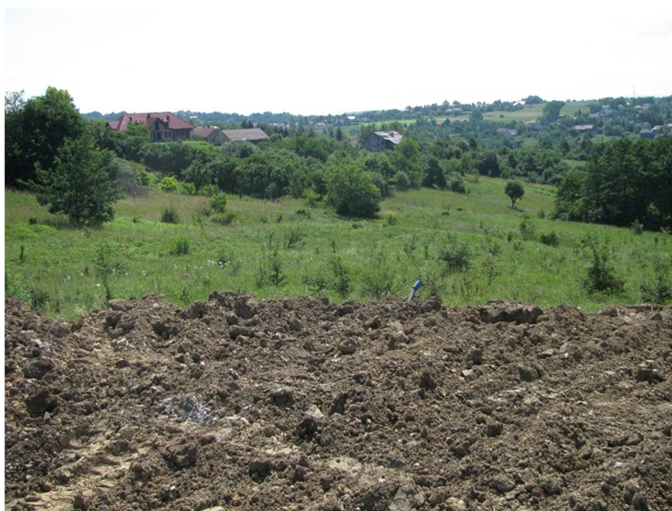
Fot.4.2. Zdjęcie zrobione z terenu budowy, poniżej stoki osuwiskowe, Soboniowice (fot. J. Kowalczuk).
