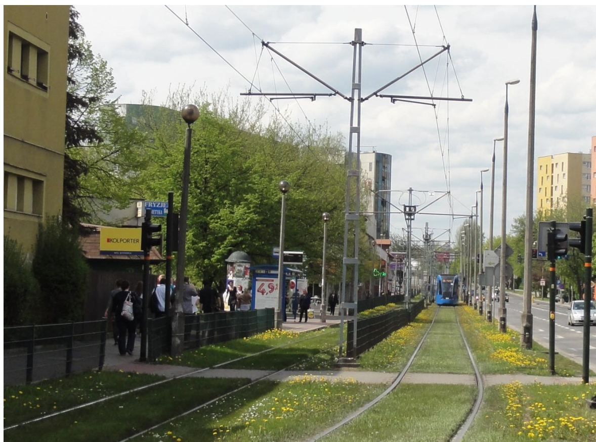
Fot. 4 Zielone torowisko w ciągu ul. Bronowickiej.
