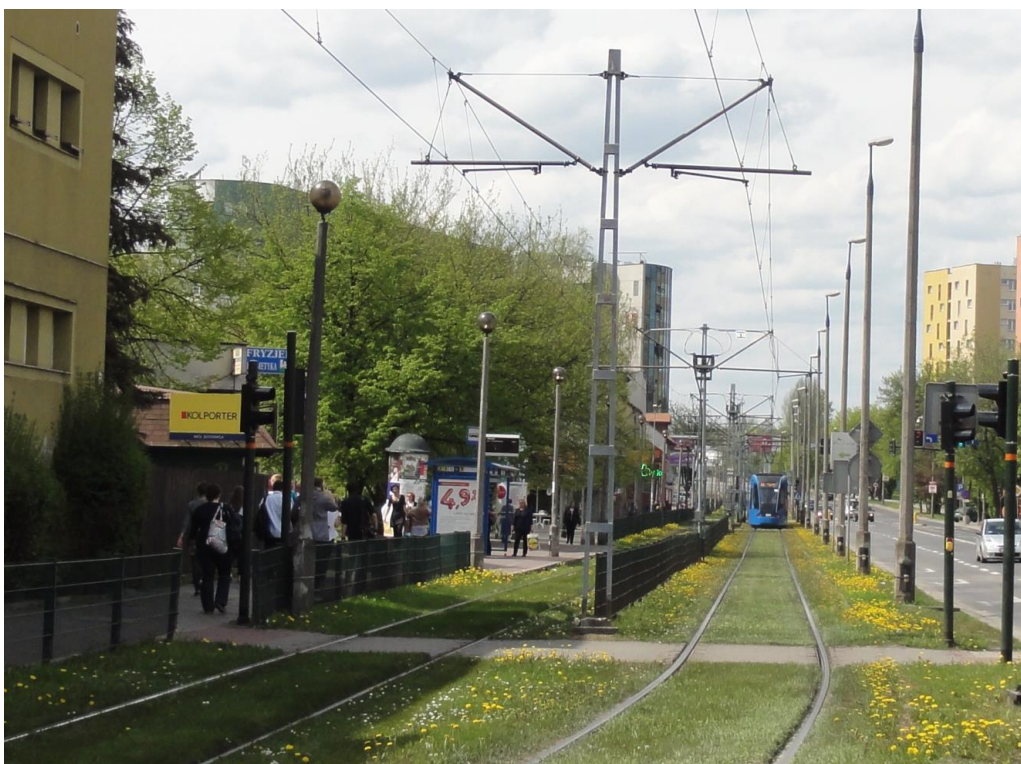
Fot. 4 Zielone torowisko w ciągu ul. Bronowickiej.
