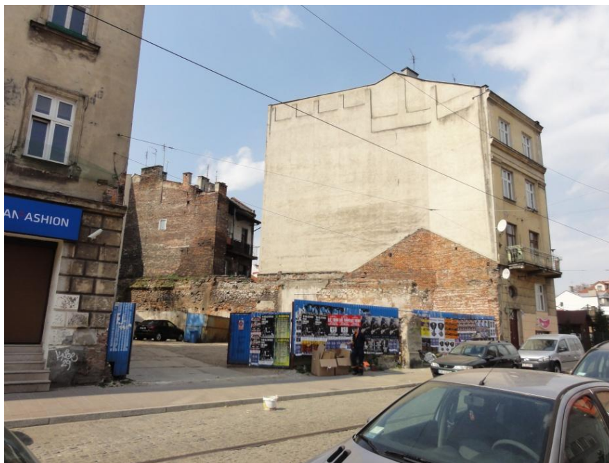
Fot. 4. Luka w pierzei przy ul. Dajwór w terenie MW/U.18,
