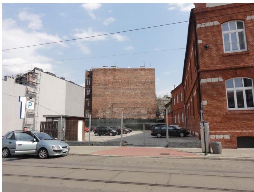
Fot. 5. Luka w pierzei przy ul. Dajwór w terenie MW/U.17,
