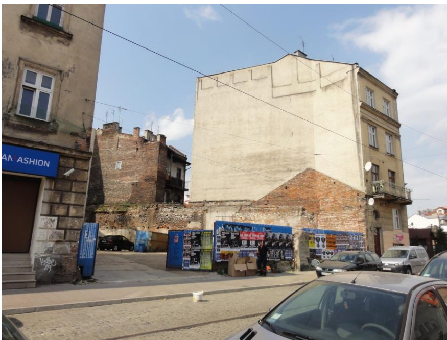
Fot. 4. Luka w pierzei przy ul. Dajwór w terenie MW/U.18,
