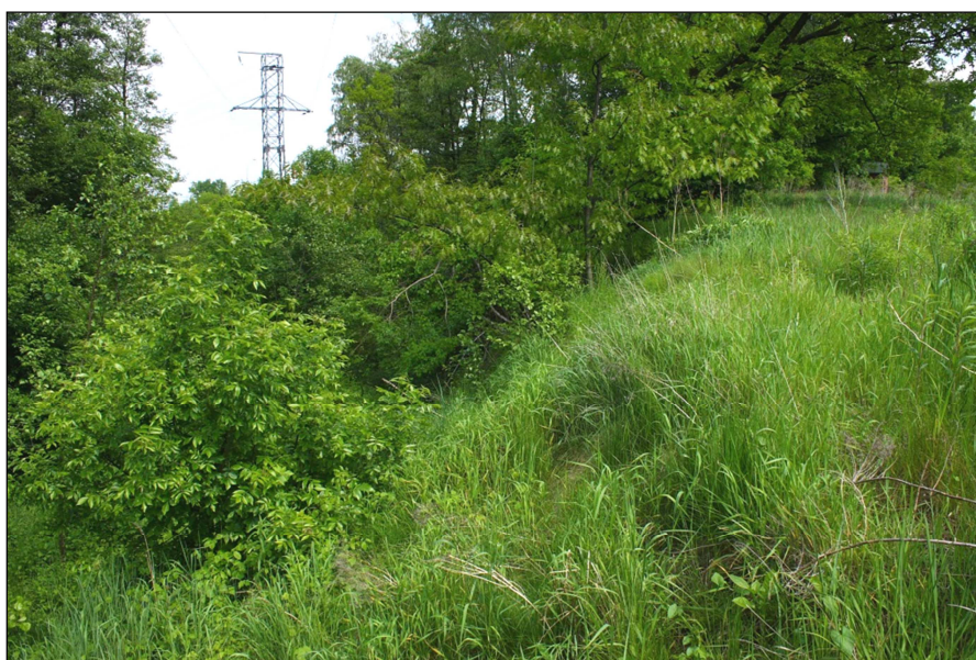
Fot. 1. Osuwisko na Szklanej Górze – skarpa główna. Widok w kierunku północno-wschodnim, 21.05.2016 r.
