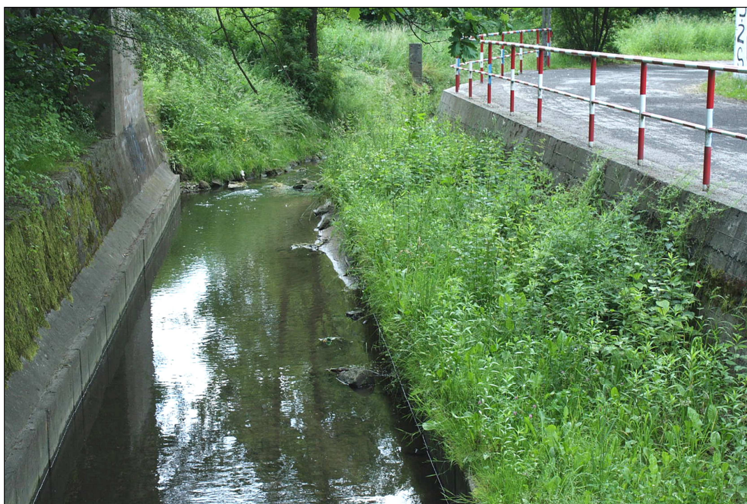
Fot. 3. Rzeka Serafa pod mostami kolejowymi, ulica Złocieniowa, widok w kierunku południowym, 12.06.2016 r.
