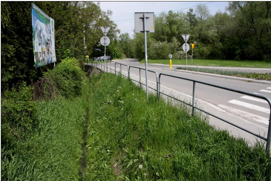
Fot. 2 Rów przy ul. Podłużnej, przy zjeździe z ronda. Widok w kierunku północnym, 15.05.2017 r.
