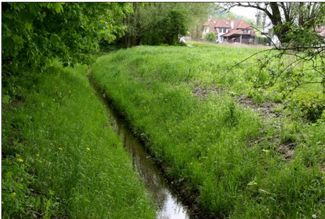
Fot. 3 Rów odpływowy przy zbiegu ulic Marynarskiej i Pylnej. Widok w kierunku południowym od przepustu przed ROD "Nad Rudawą", 15.05.2017 r.
