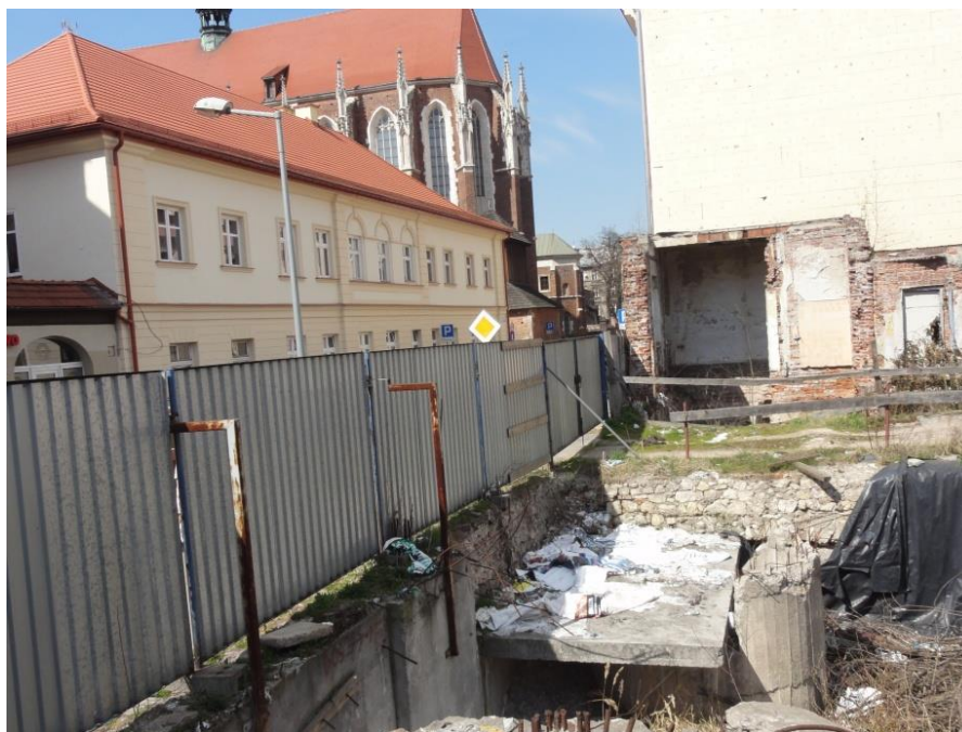
Fot. 3. Narożnik kwartału zabudowy w terenie MW/U.46 (przy skrzyżowaniu ulic Węglowej i Augustiańskiej)
