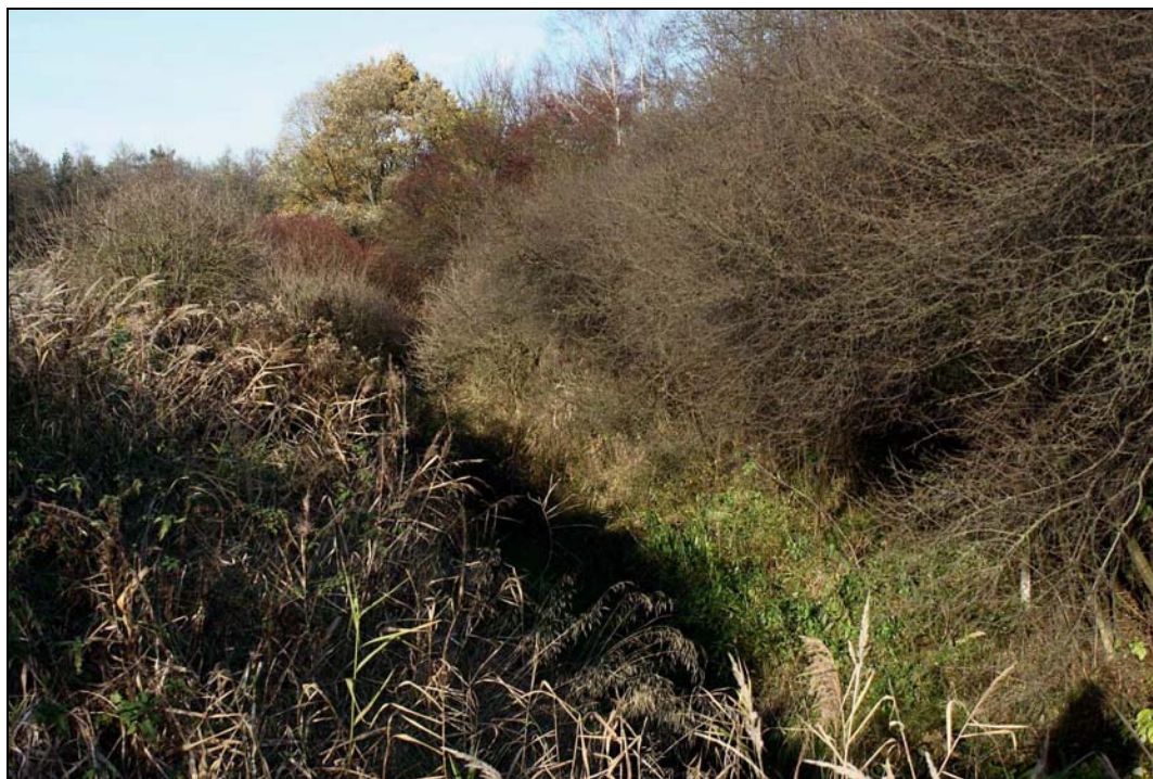
RYC. 13. RÓW ODPLYWOWY OD PRZEPUSTU POD AUTOSTRADĄ A4 Dopływ P. Kostrzeckiego, widok w kierunku wschodnim, 04.11.2016 r.
