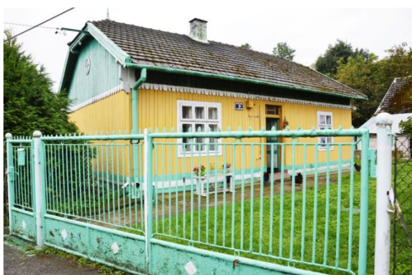
Fot. 10 Budynek mieszkalny z dachem naczółkowym.
