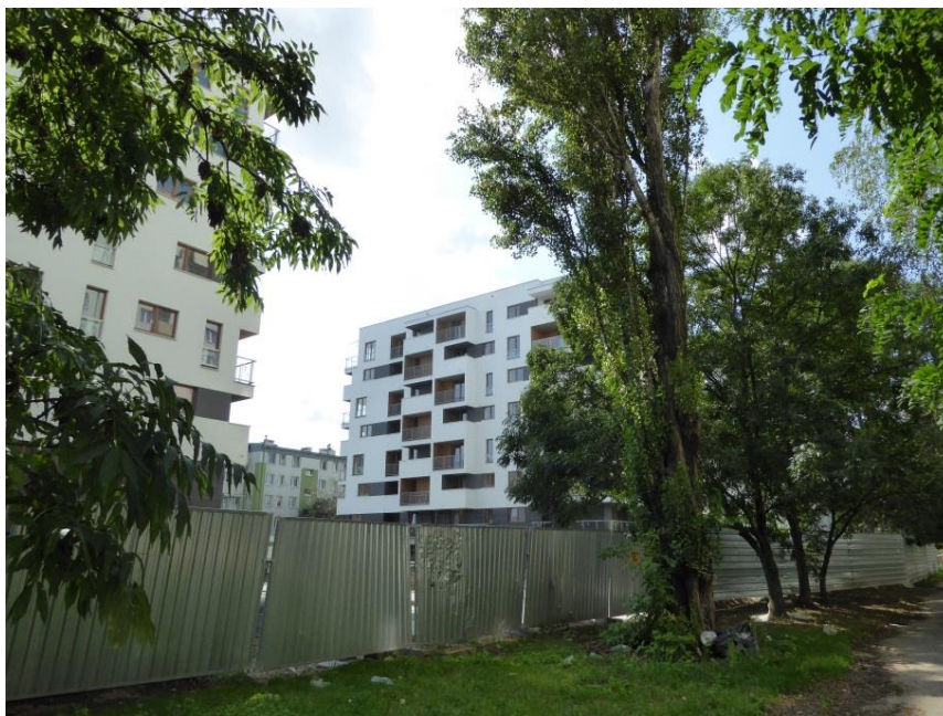
Fot. 5. Nowe bloki powstałe za blokiem Pachońskiego 6.
