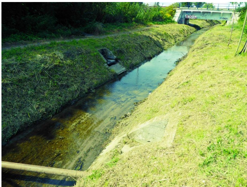
Fot. 11. Potok Sudół przepływający pod torami kolejowymi w północnej części obszaru.
