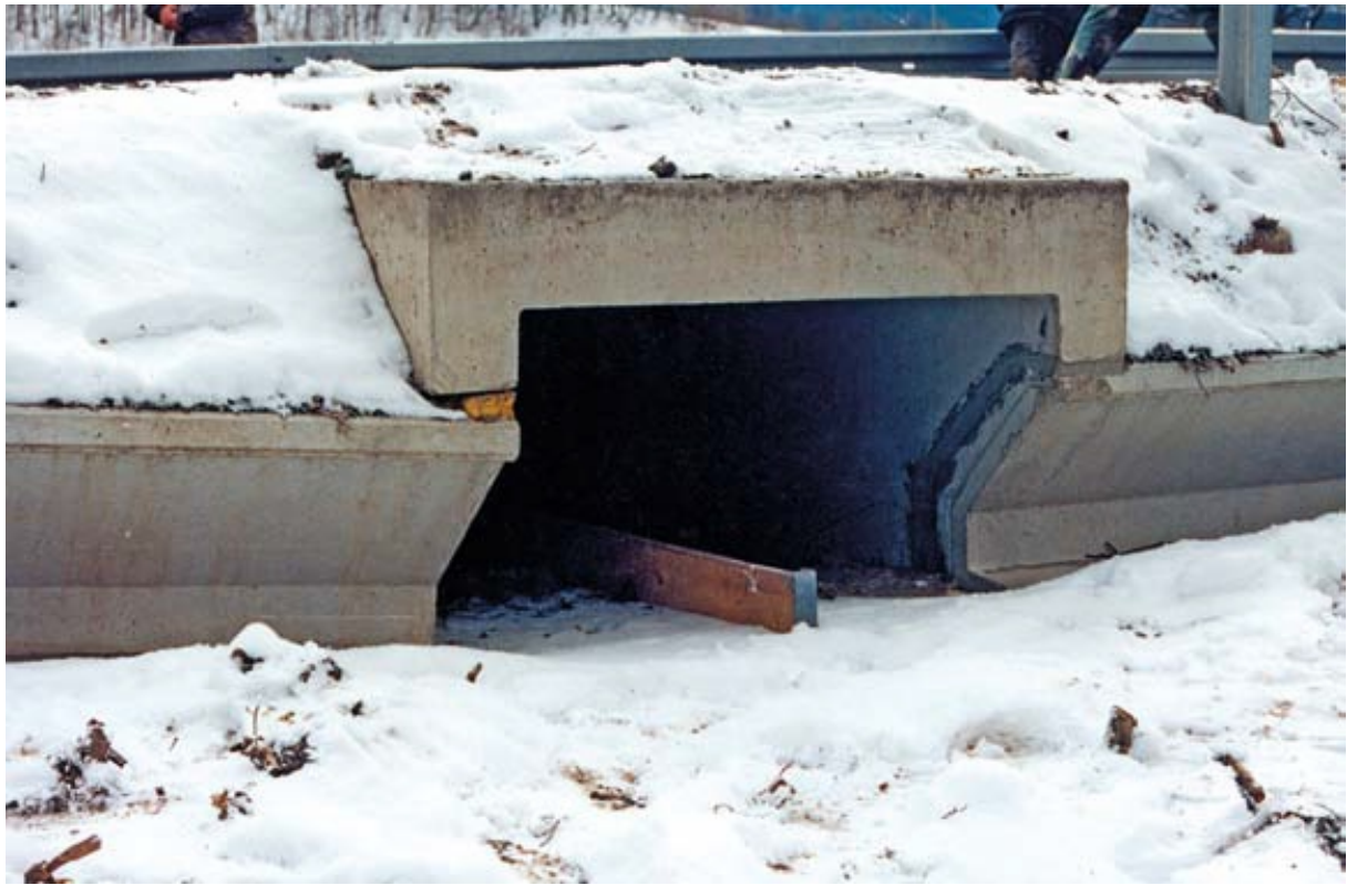
Fot. 1. Przejście dla zwierząt. Szerokość minimalna: 1m; wysokość minimalna 0,5 m (Kurek i in. 2011).
