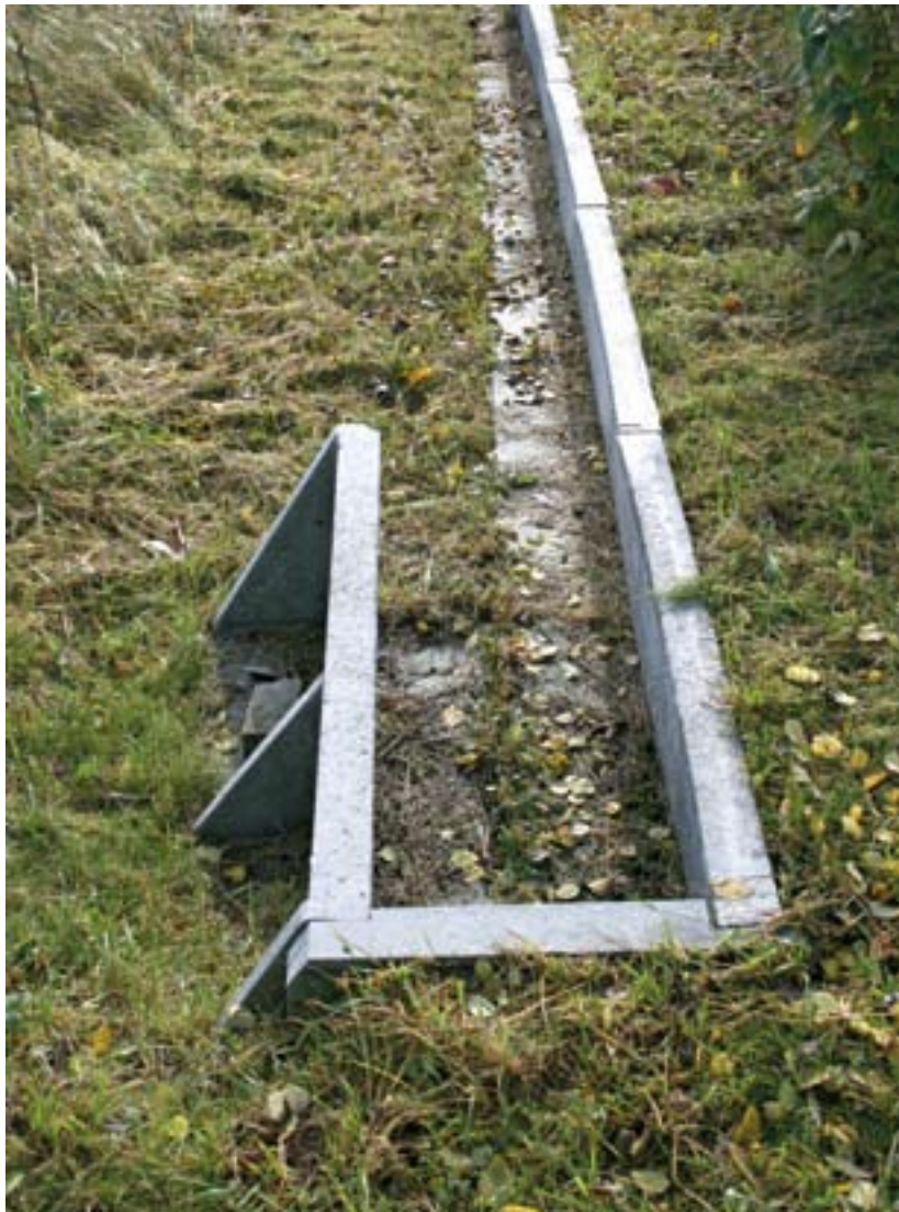
Fot. 3. Zakończenie murku naprowadzającego do przejścia dla płazów (Kurek i in. 2011).
