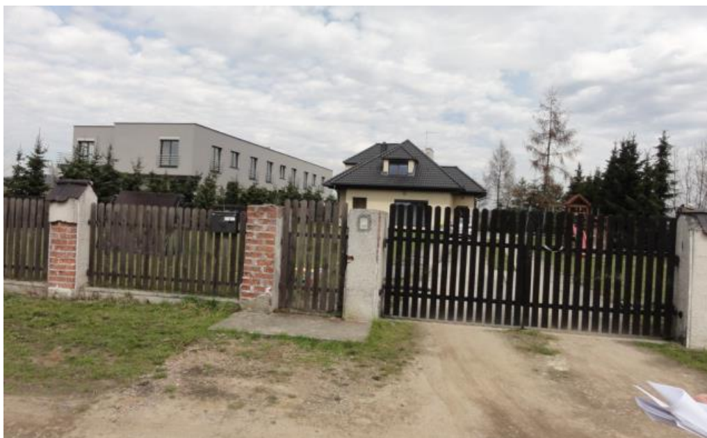
Fot. 12. Zabudowa o różnym charakterze i gabarytach powstająca na granicy obszaru opracowania (budynek z lewej znajduje się poza granicą projektowanego planu) (fot. Prochwicz S., kwiecień 2018 r.).
