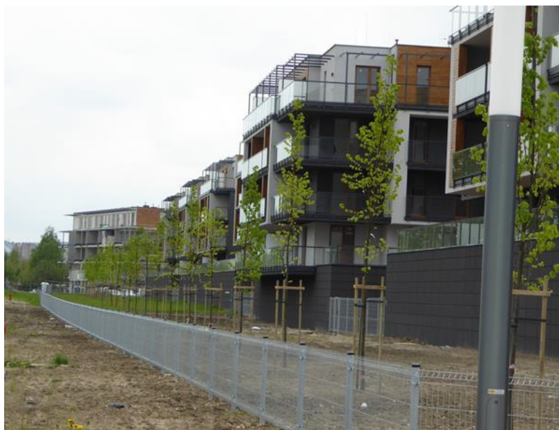
Fot. 9. Zabudowa nowego osiedla mieszkaniowego.
