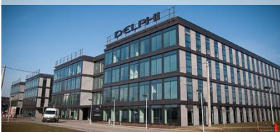
Sawig Office – ul. Wadowicka
