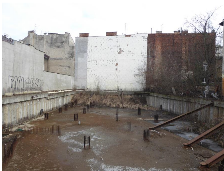
Fot. 6. Porzucona budowa przy ul. Lwowskiej.
