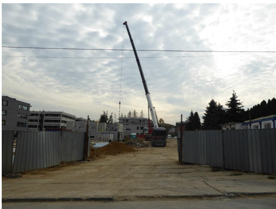
Fot. 10. Trwająca budowa budynków mieszkaniowych wielorodzinnych przy ul. Skowroniej (październik, 2018r.)
