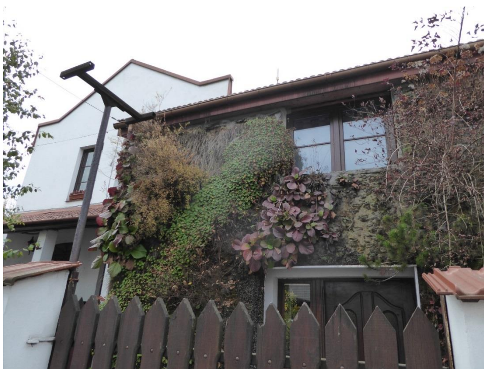
Fot. 3. Ogród urządzonej na ścianie budynku tzw. „zielona ściana” (budynek przy ul. Mochnackiego).
