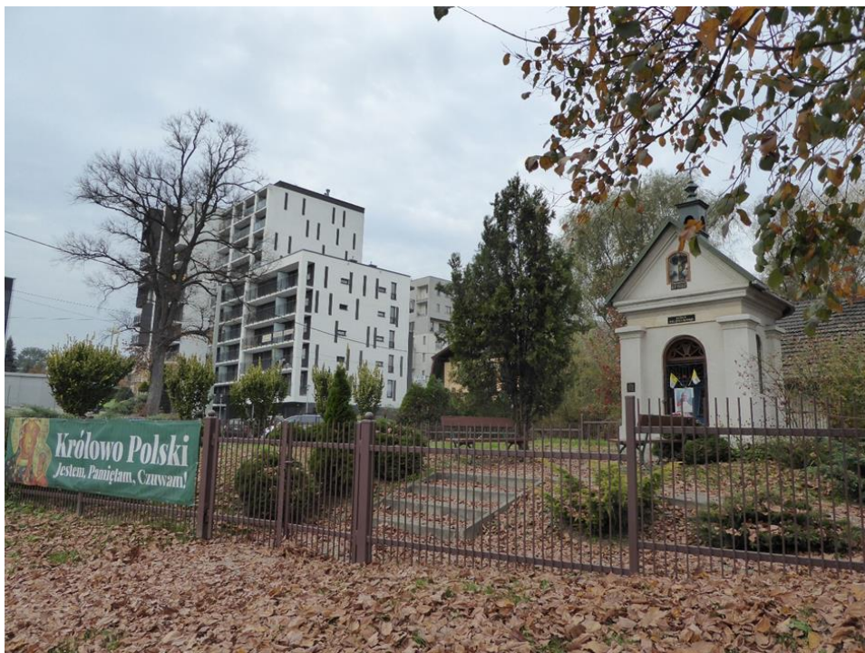
Fot. 6. Murowana kapliczka domkowa z 1882 r. przy ul. Malborskiej. W tle nowa zabudowa wielorodzinna przy ul. Walerego Sławka (poza granicami obszaru opracowania).
