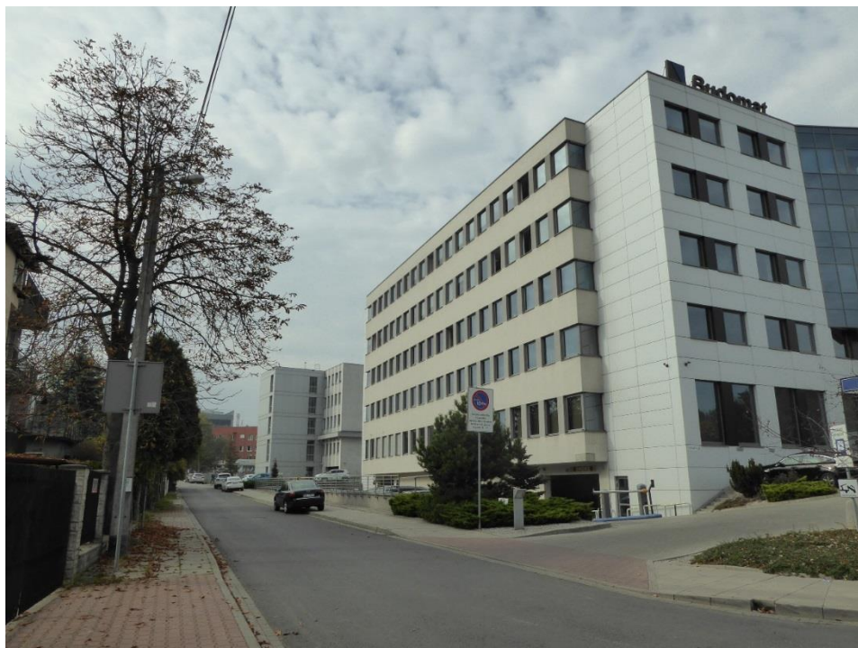
Fot. 14. Zabudowa usługowa przy ul. Pańskiej – bezpośrednie sąsiedztwo granic opracowania
