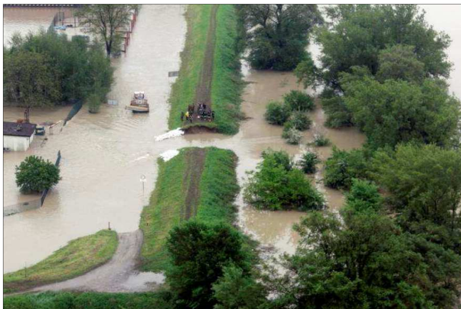
Fot. 9. Przerwane obwałowanie przy ul. Na zakolu Wisły /źródło: Raport po powodzi z maja i czerwca 2010r. [53].
