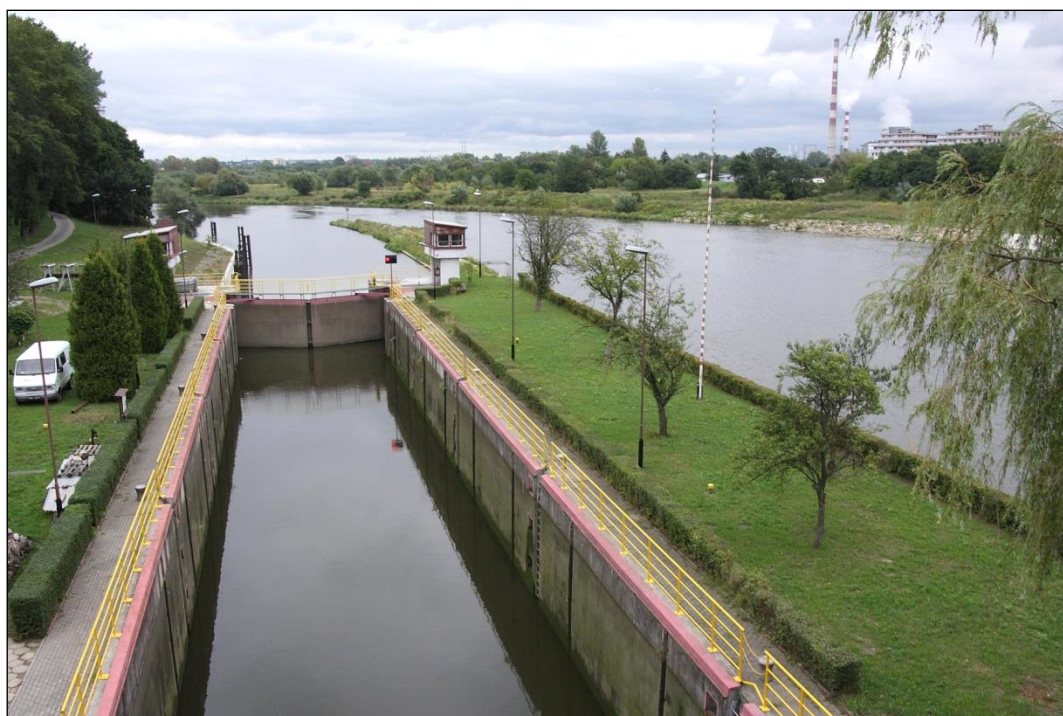
Fot. 2. Stopień wodny Dąbie – śluza żeglugowa i stanowisko dolne. Widok w kierunku wschodnim, z mostu w ciągu ul. Ofiar Dąbia, 02.09.2017 r.
