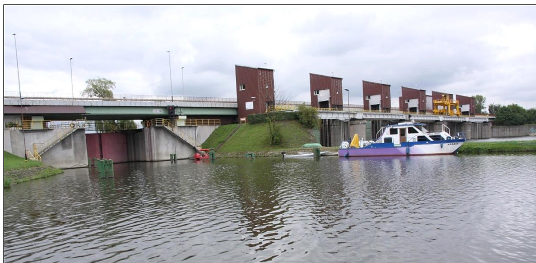
Fot. 1. Stopień wodny Dąbie – stanowisko górne. Widok w kierunku południowo-wschodnim, 02.09.2017 r.
