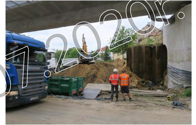
Ciężki sprzęt przy pracy nad usuwaniem nasypu
