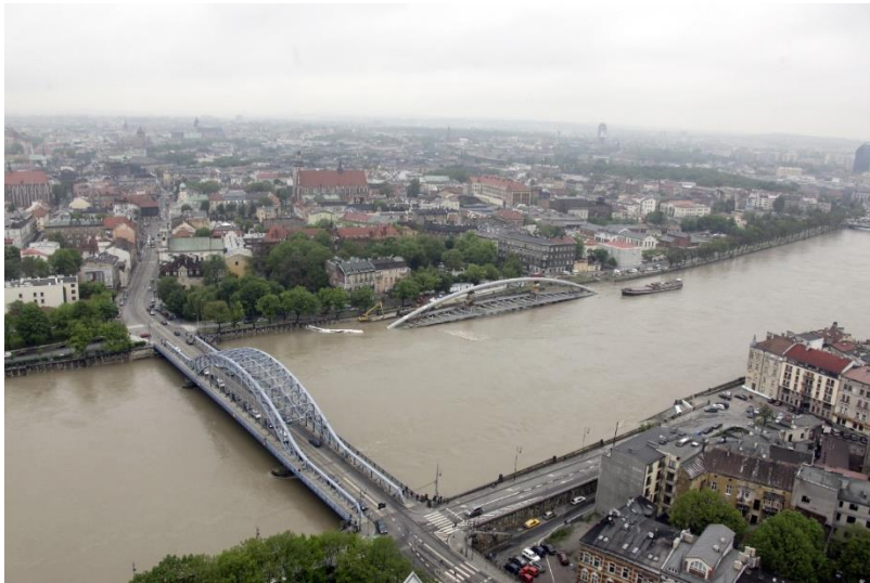
Fot. 2. Widok z lotu ptaka na Most Piłsudskiego i jeszcze nie zamontowaną kładkę Bernatka w czasie powodzi w maju 2010 r. (źródło: Magiczny Kraków).
