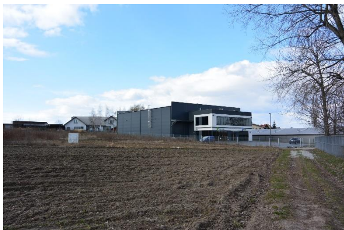
Zabudowa usługowa oraz produkcyjna w rejonie ul. Powstańców
