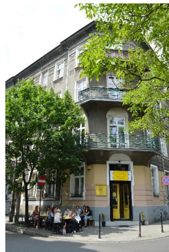
Fot. 20. Kamienica z wbudowaną usługą gastronomiczną „Pierogarnia”.
