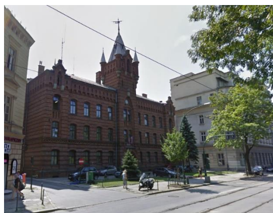
Fot. 18. Budynek Komendy Miejskiej Państwowej Straży Pożarnej.
