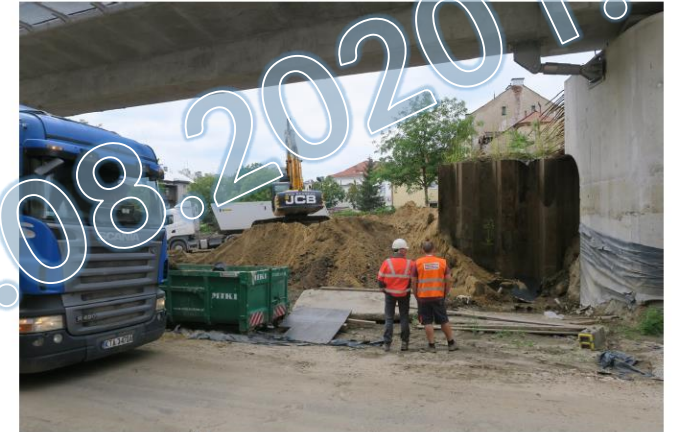
Ciężki sprzęt przy pracy nad usuwaniem nasypu
