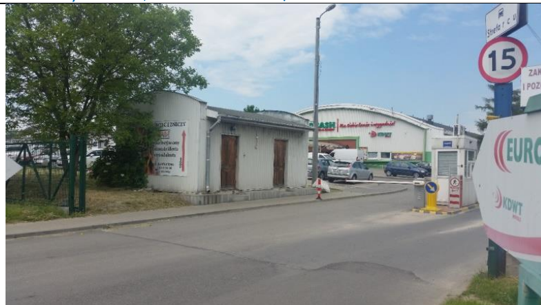
Teren U.5- istniejąca zabudowa przy ul. Lindego, widok w kierunku północno-zachodnim (fot. Pracownia Urbanistyczna BP, czerwiec 2019 r.)
