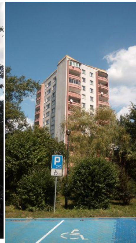
Zabudowa mieszkaniowa wielorodzinna przy ul. Pachońskiego
