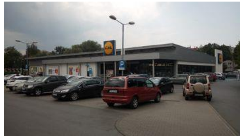
Zabudowa usługowa przy ul. Siewna – Sklep Lidl
