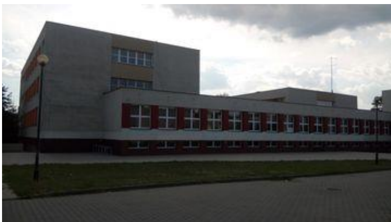
Zabudowa użyteczności publicznej – Szkoła Podstawowa nr 109 – przy ul. Mackiewicza
