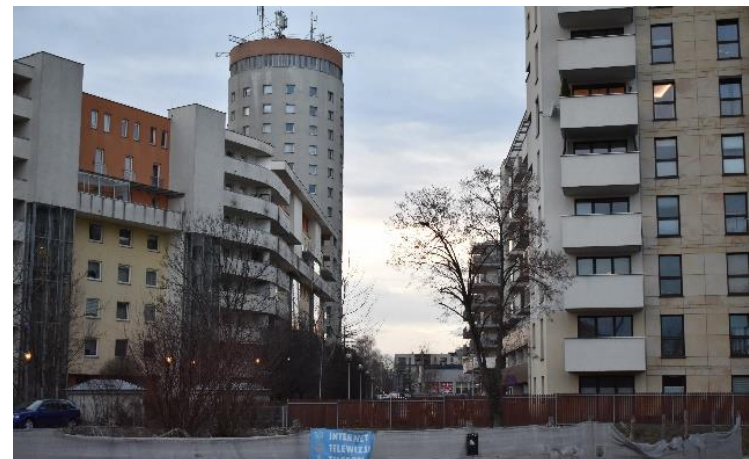
Zabudowa mieszkaniowa wielorodzinną przy ul. Bociana
