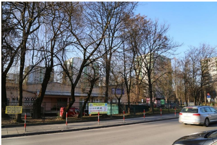
Fot. 12. Zieleni terenów zainwestowanych w południowej części obszaru, ul. Grażyny. (fot. M. Chrzęszczuk, 8.02.2020 r.)
