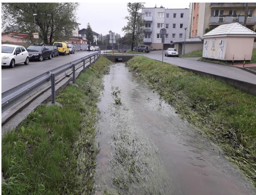
Fot. 7. Potok Młynny Kobierzyński po intensywnych opadach w maju 2019 – po częściowym opadnięciu poziomu wody.
